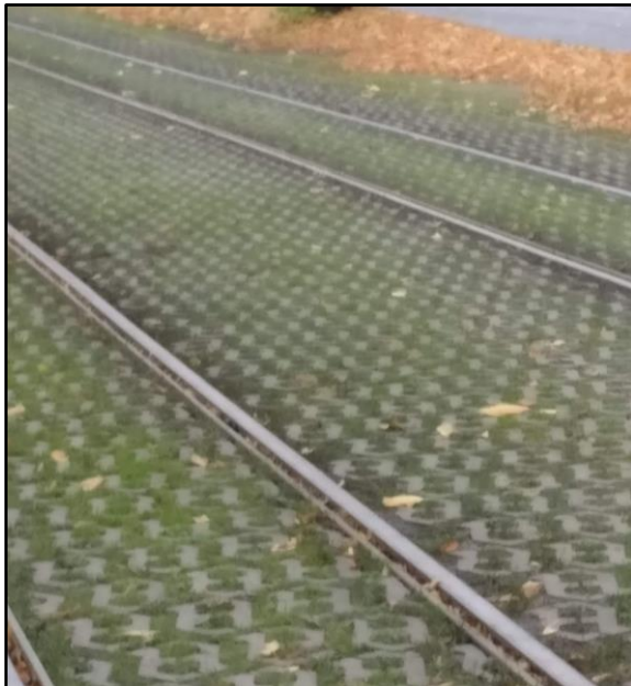
Kuva 12 Ruoho-/sorakiveys on esimerkki hulevesien määrää vähentävästä piha-alueen materiaaliratkaisusta (kuva AFRY Finland Oy)
