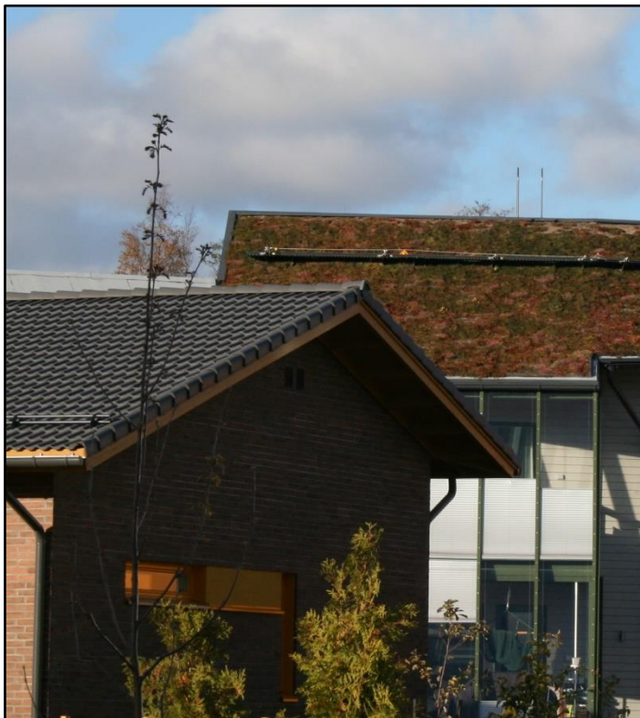
Kuva 13 Viherkatto on esimerkki hulevesien määrää vähentävästä tonttikohtaisesta ratkaisusta (kuva AFRY Finland Oy)
