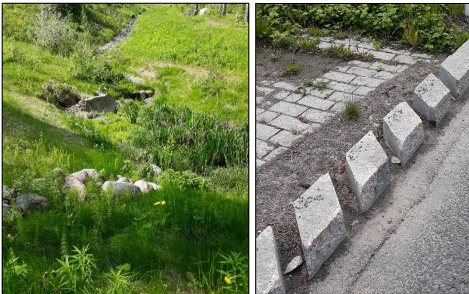
Kuva 15 Esimerkit a) vehreästä avouomasta, joka toimii tiiviin kasvillisuuden ja mutkittavuuden ansiosta myös hulevesiä viivyttävänä ja niiden laatua parantavana ratkaisuna sekä b) rakoreunakivestä, jota kautta hulevedet voidaan ohjata hulevesirakenteeseen sekä vehreästä avouomasta, joka toimii tiiviin kasvillisuuden ja
